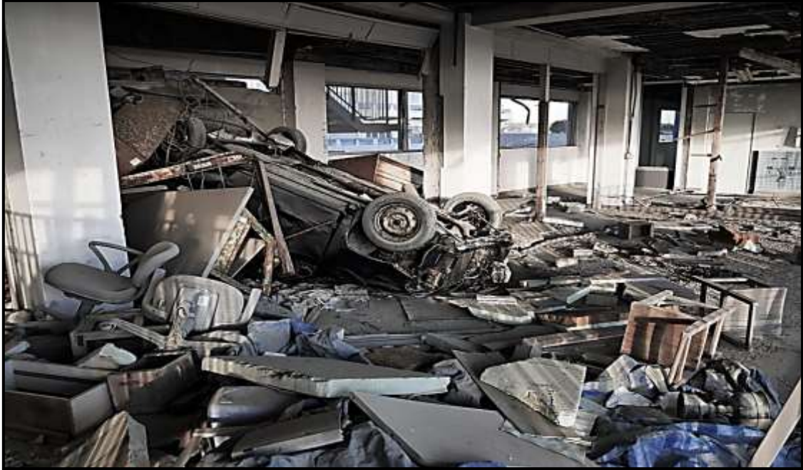
Şekil 2. Büyük Doğu Japonya Depremi Harabeleri Kesennuma Şehri Anıt Müzesi İç Görünüm (Kaynak: https://www.tohoku-golden-route.com/wp-content/uploads/2020/01/2019-12-24-15.43.33r-scaled-1.jpg )
